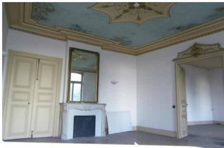
Au 1 o étage, vue du salon principal de la maison au 2 rue Haute-Pierre à Metz où est né Verlaine
