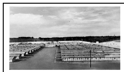
Le camp de Leucate / Port la nouvelle
